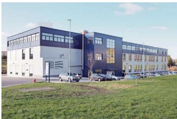
Edificio di produzione e amministrazione nella Svizzera orientale
