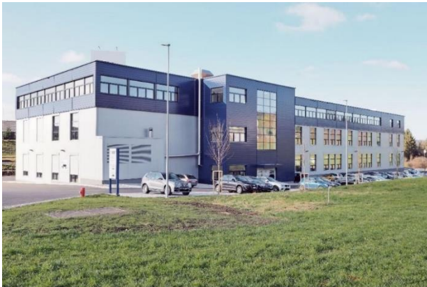
Produktions- und Verwaltungsgebäude in der Ostschweiz
