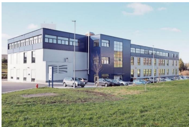
Bâtiment de production et d'administration en Suisse orientale
